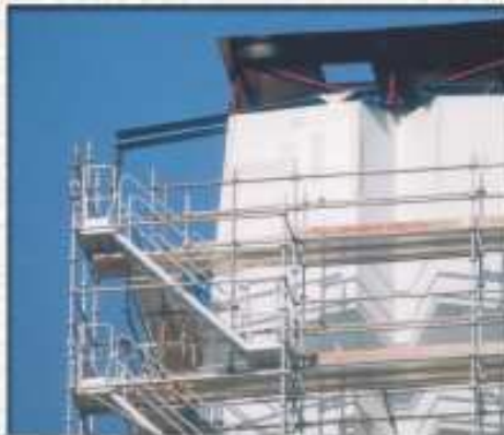
Viaduc de Millau
