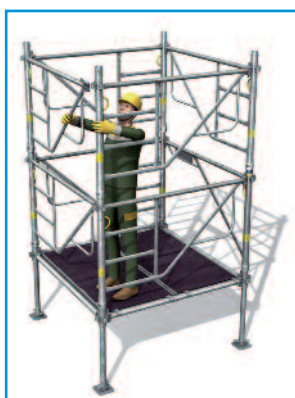
4 - Pose de 2 planchers à trappe et montage du 2 e niveau.
