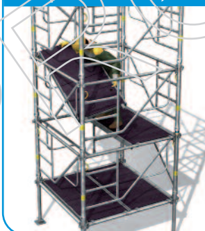
8 - Déplacement du 1 er plancher à trappe.
