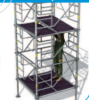
9 - Déplacement du 2 e plancher à trappe depuis le niveau inférieur.
