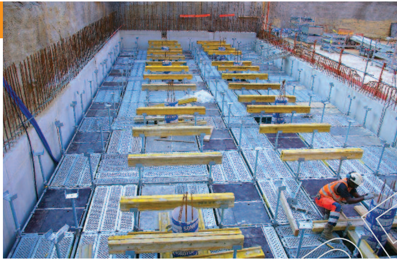
Pose des poutres à partir du platelage en tête de tour.
