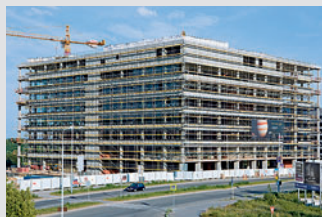
Echafaudages de façades
