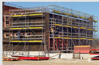
Echafaudages de ferrailage
