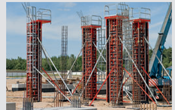
Coffrages de poteaux
