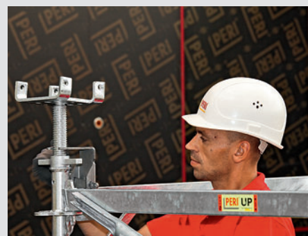
Le travail en tête de tour se fait toujours avec un accès sécurisé et aisé aux vérins de réglages.
