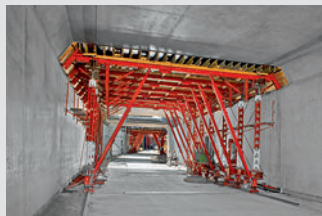
Coffrages de tunnels
