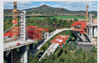
Coffrages de ponts
