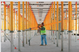
Coffrages de dalles
