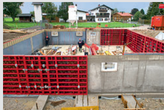
Coffrages de voiles
