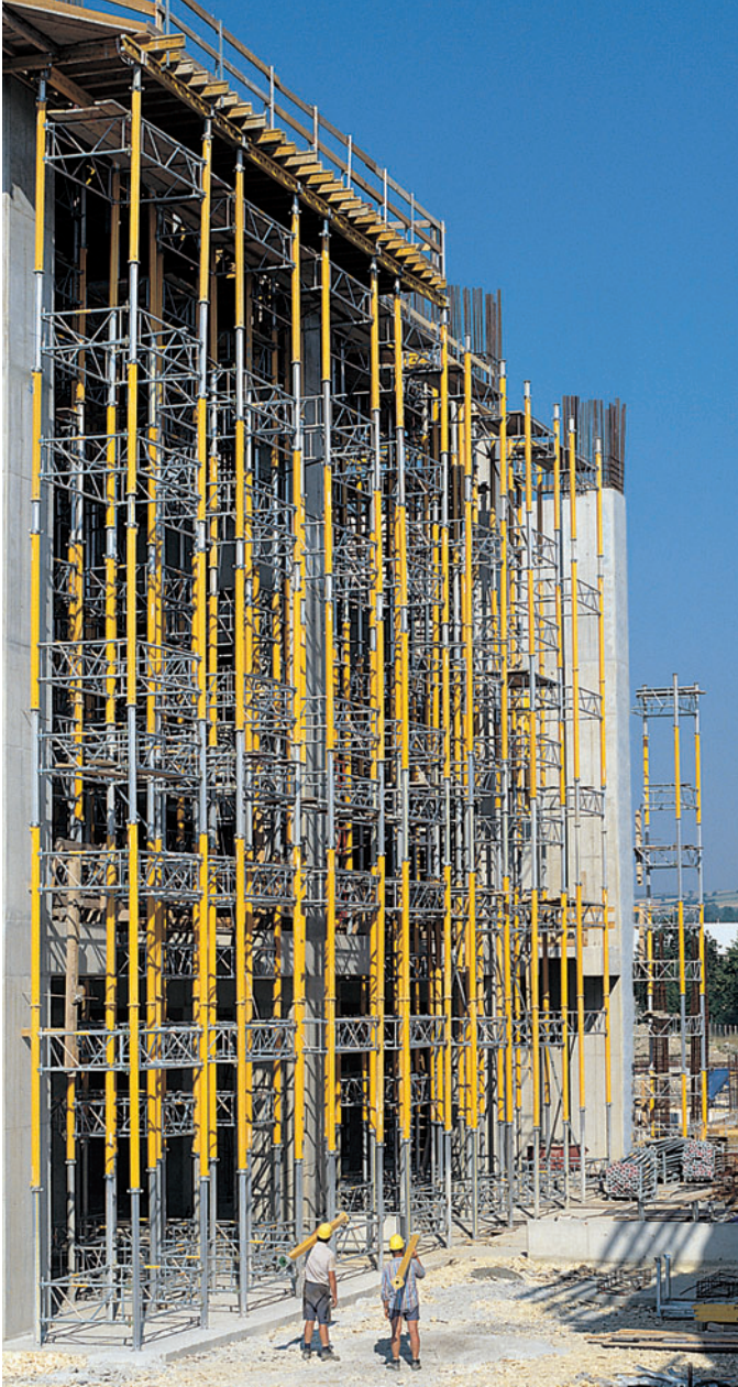
Tours MULTIPROP, hautes de 20 m, pour l'étaie-ment d'une dalle en encor- bellement.
