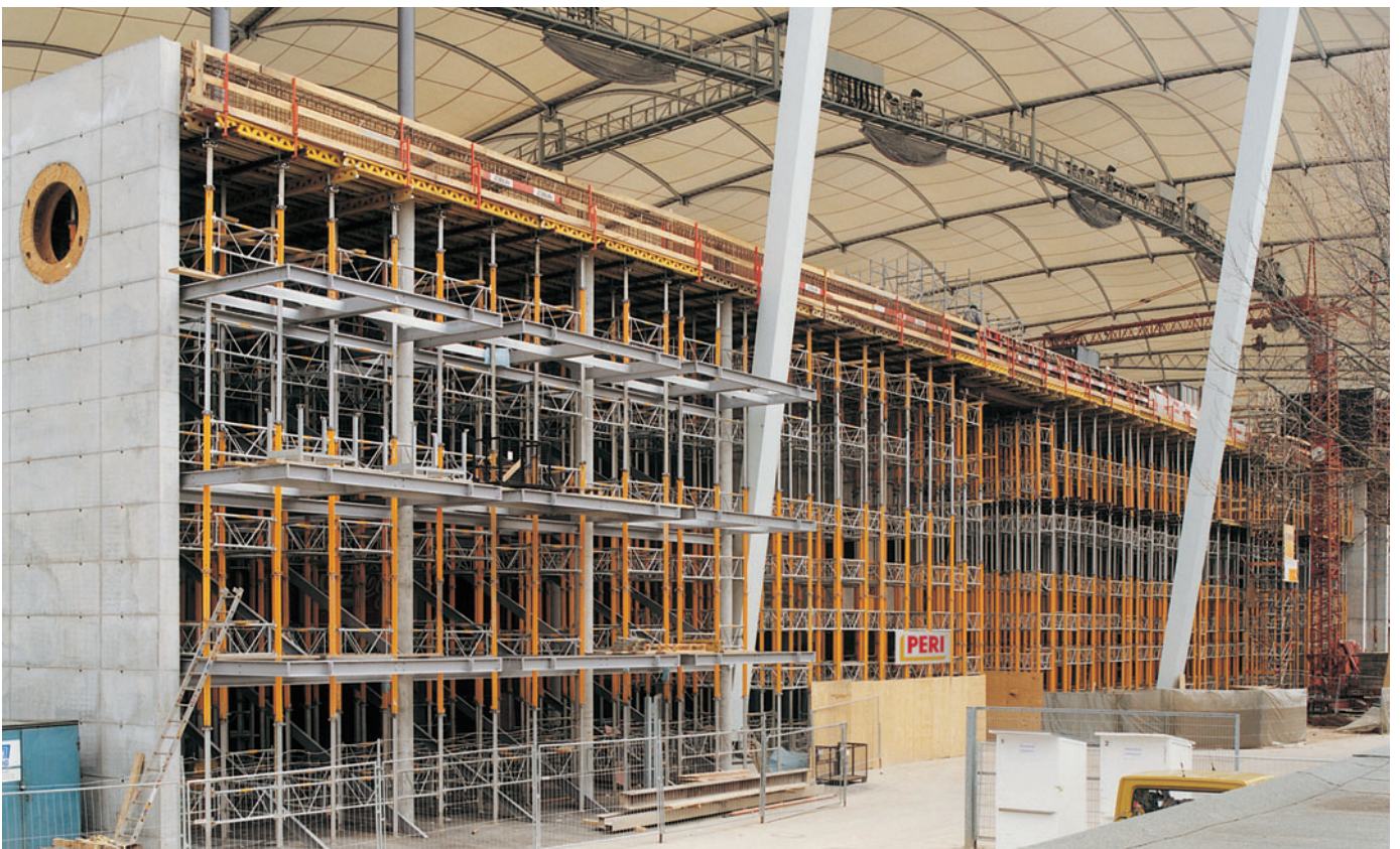
Reprise fiable de charges élevées: étaie- ment MULTIPROP, haut de 14,00 m, sur une surface de 3.500 m 2 .
