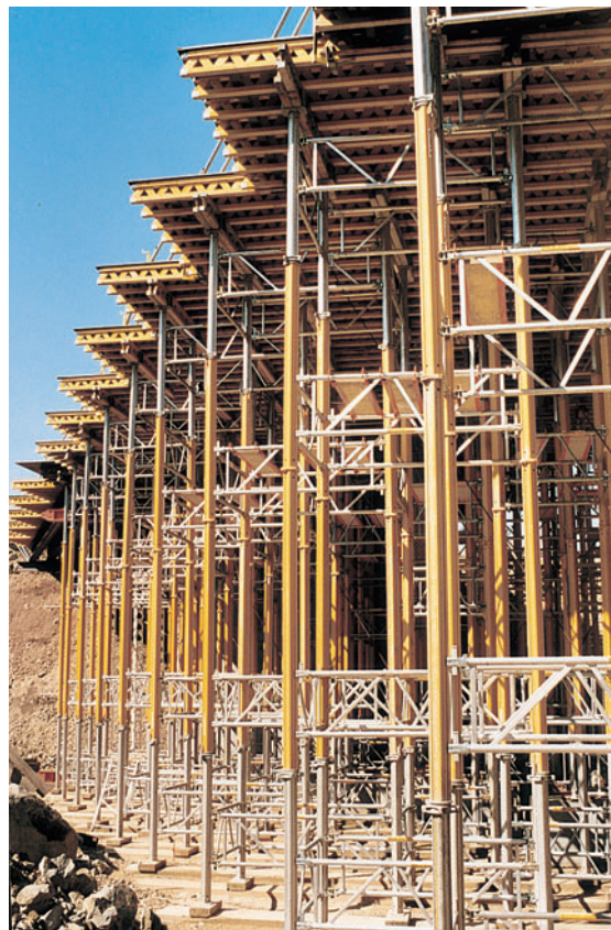
Tours MULTIPROP de 8,80 m de haut utilisées pour étayer des tables de coffrage.
