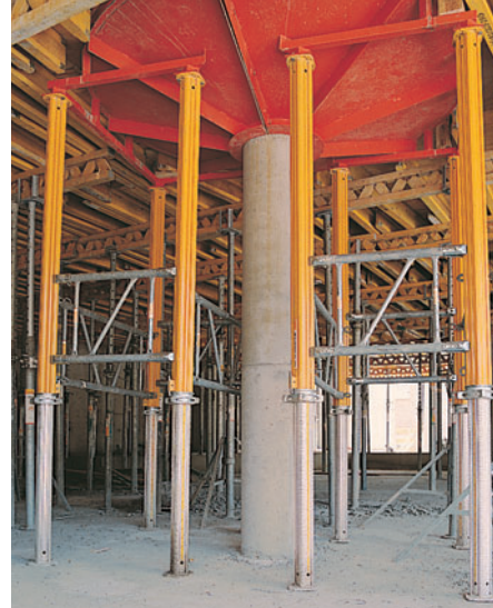
Tours MULTIPROP, hautes de 20 m, pour l'étaie-ment d'une dalle en encor- bellement.
