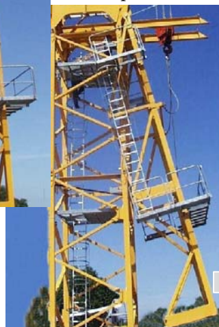
Démontage 2ème partie
