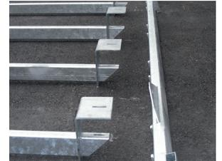
Einführen der Wange in die Querholmen. Die auf den Wangen aufgeschweissten Führungsnocken markieren und zentrieren die Position der Querholme.
