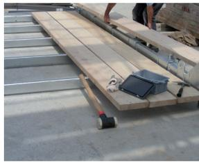
Schliessen des Gerüstbelages mit dem Abschluss-Querholmen mit Hebelschrauben und Hebelmuttern, M16/90 mm.
