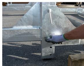
Einfügen und verschrauben des frontseitigen Querholmens, Hebelschrauben und Hebelmutter, M16/90 mm.
