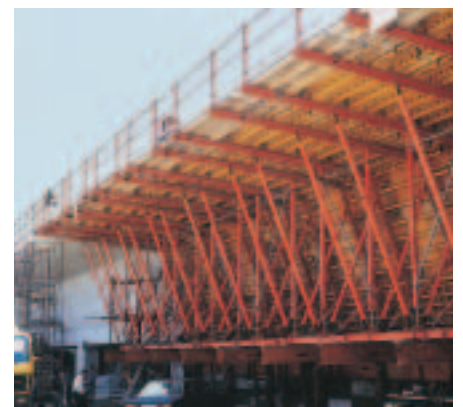
La poutrelle GT 24 lors de la construction d'un coffrage d'un caisson pour une superstructure de pont.
