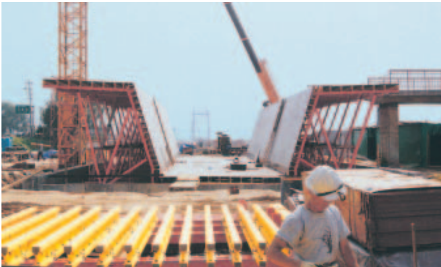
La poutrelle GT 24 lors de la construction d'un coffrage d'un caisson pour une superstructure de pont.
