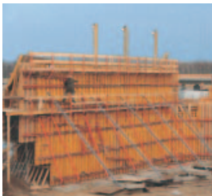
Culées de pont complexes avec VARIO GT 24.
