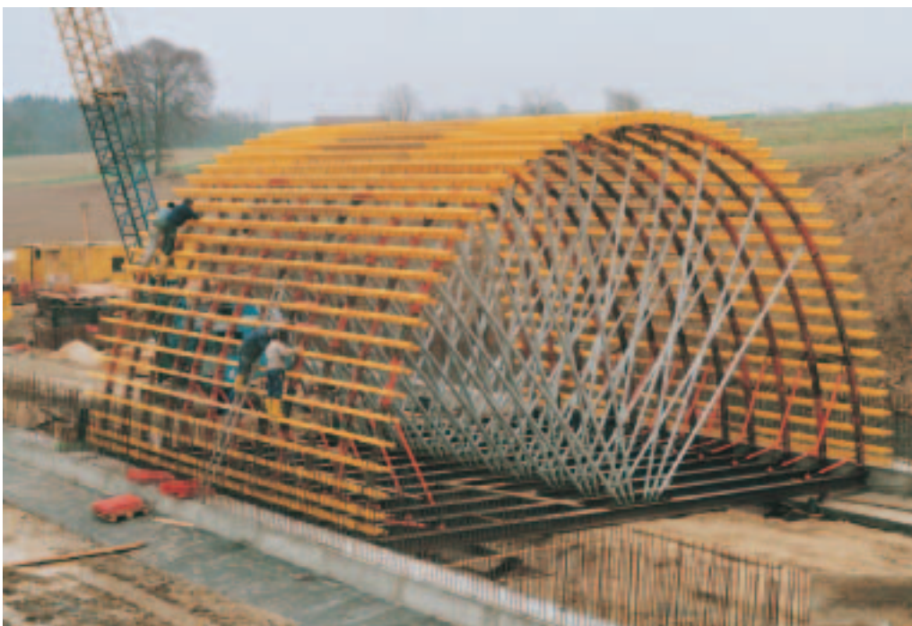
Coffrages de tunnel avec poutrelles GT 24 extra-longues (l = 9,0 m).
