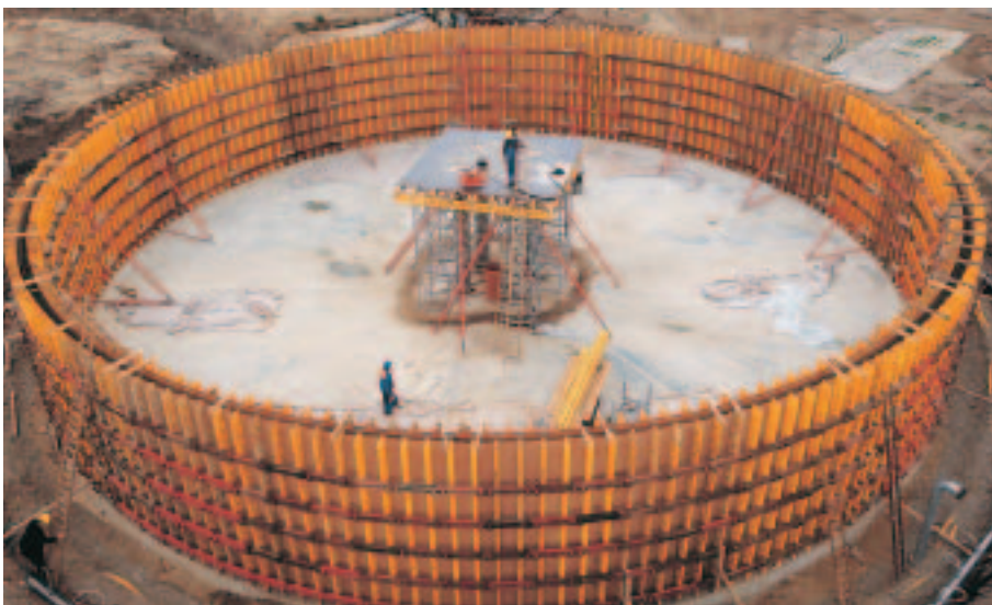
Réservoir circulaire complet coffré sans ancrage avec GRV et poutrelles GT 24.
