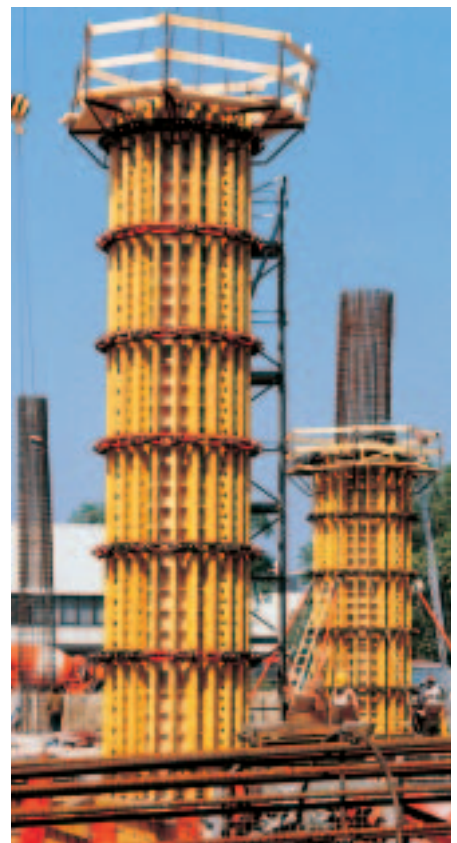
PERI GRV et poutrelles GT 24 utilisés sous forme de coffrage à tracé conique.
