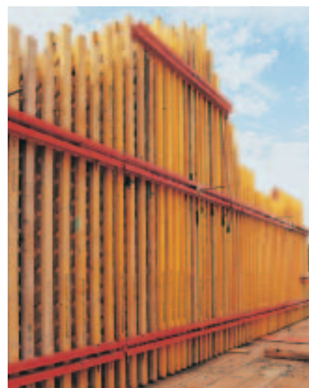
Le pas de 30 cm de la poutrelle GT 24 permet de l'adapter facilement à la hauteur requise. Ci-dessus un voile pignon destiné à la construction d'un logement.
