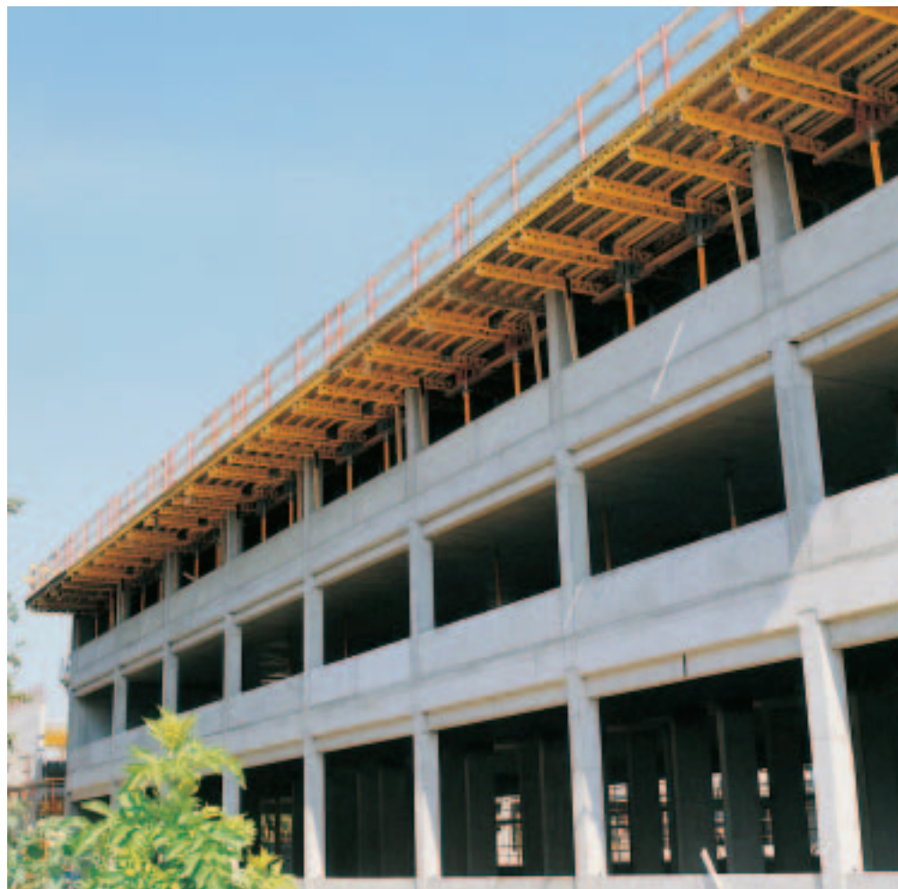
MULTIFLEX GT 24 et MULTIPROP 350 s'harmonisent à la perfection.
