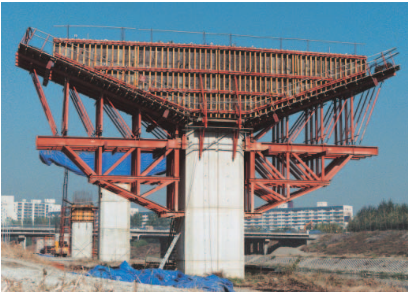
Coffrage de chevêtre destiné à une autoroute de ville en Corée.
