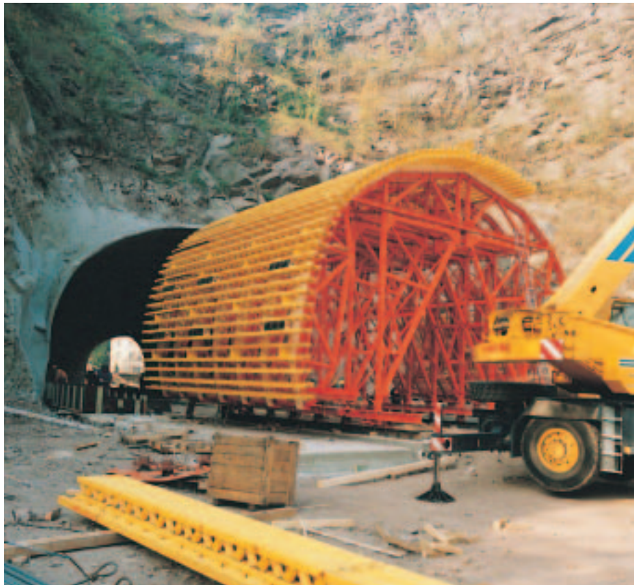
Coffrages de tunnel avec poutrelles GT 24 extra-longues (l = 9,0 m).
