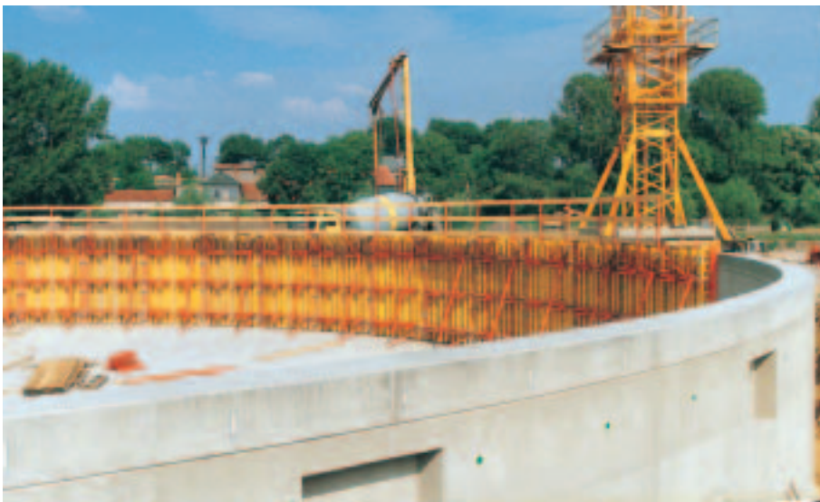
Station d'épuration coffrage avec RUNDFLEX.
