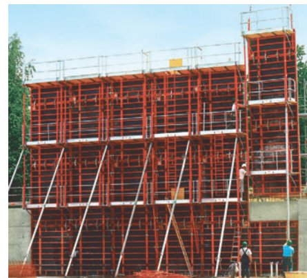
TRIO dans la construction industrielle.
