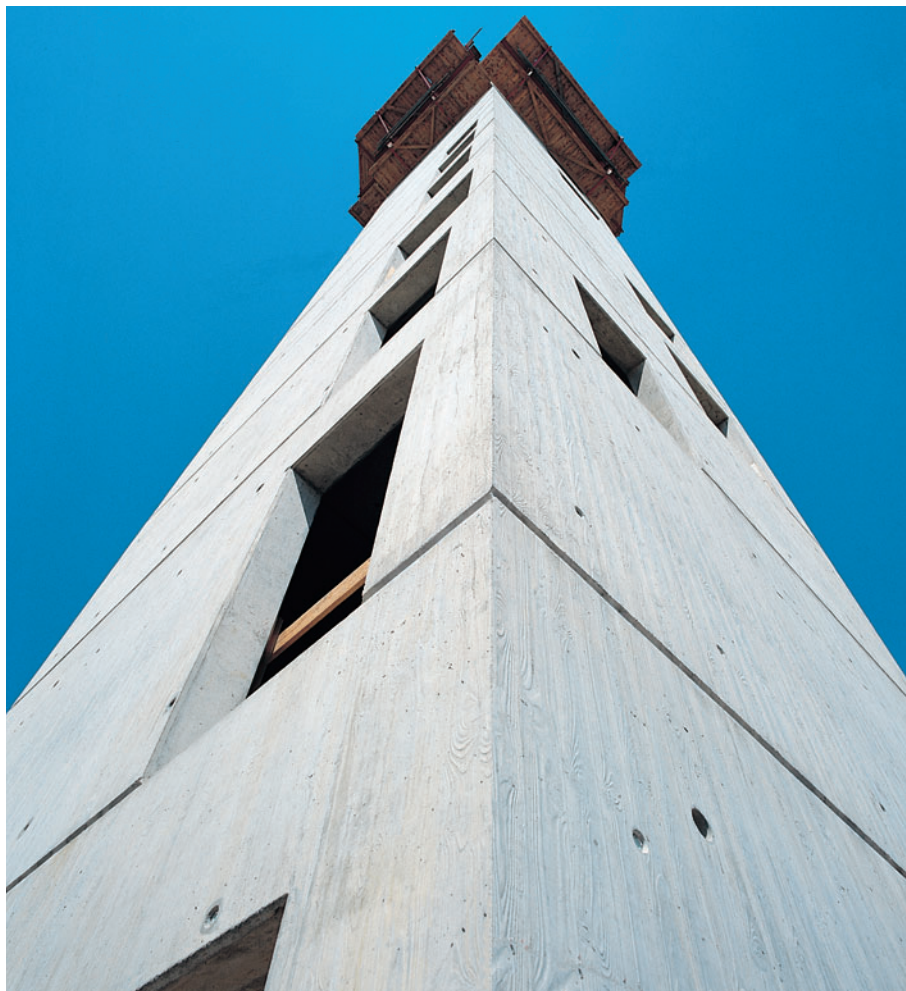
Surface de béton esthétique portant l'empreinte d'un veinage bois vertical à surface rugueuse.
