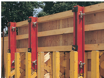
Superposition de madriers de 60 cm de haut. Ultra-simple à l'aide de l'aboutage 24.
