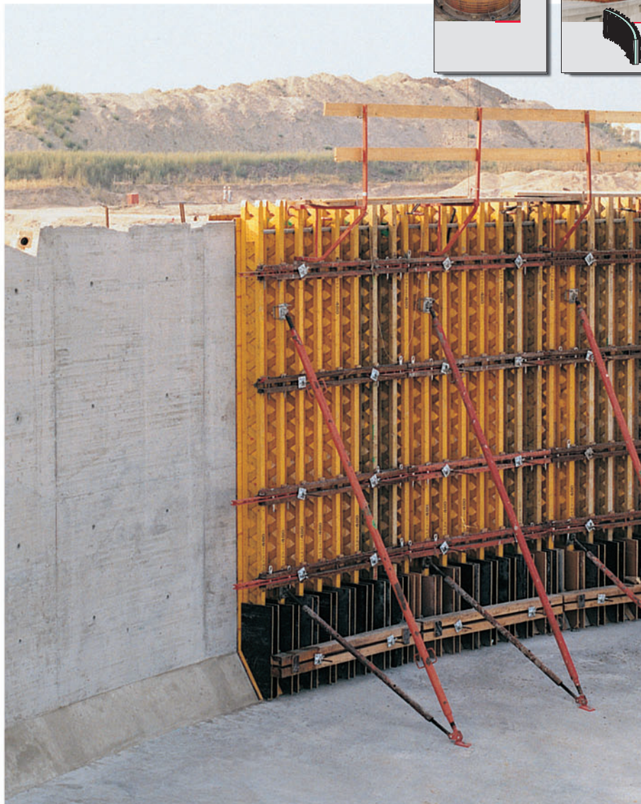
Le coffrage de gousset fait partie intégrante du coffrage VARIO.
