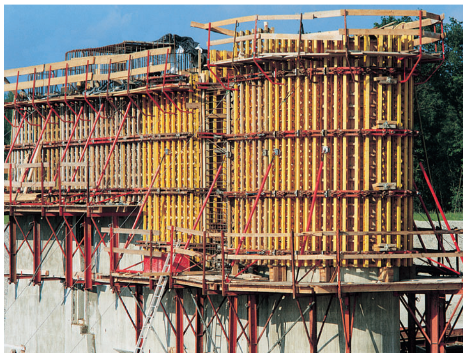
Partie avant des piles de barrage. VARIO associé au système de coffrage circulaire GRV sur console grimpanse KGF 240.
