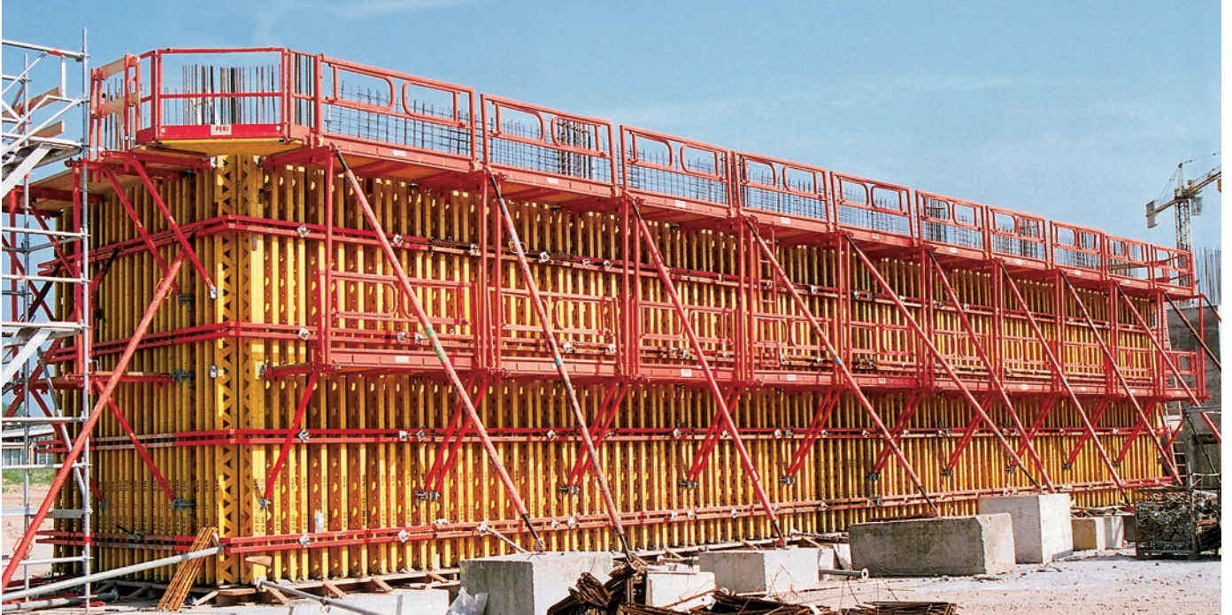
VARIO GT 24 - hauteur 6,00 m Éléments standards avec passerelles.
