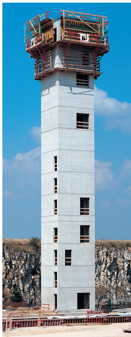
Tour de 43,50 m de haut avec béton apparent portant l'empreinte du veinage bois pour une installation industrielle.
