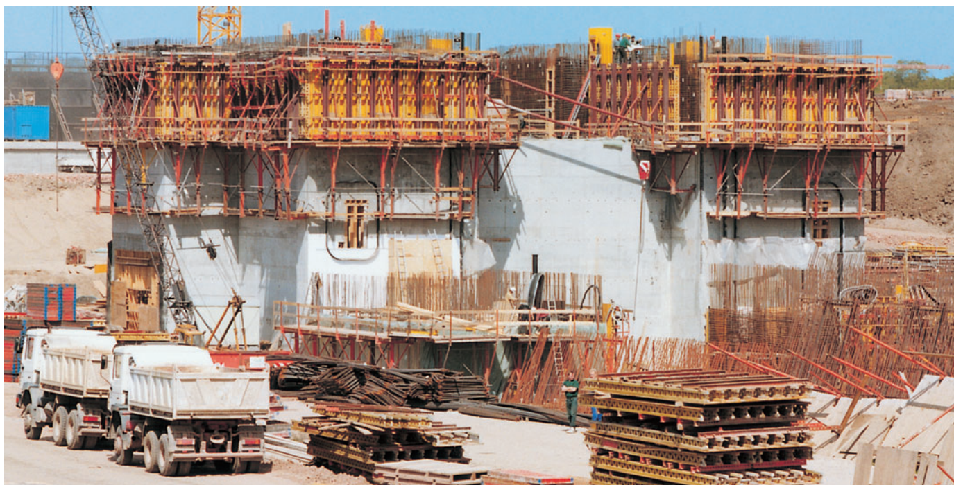
Unité complète: VARIO GT 24 sur console grimpan- te une face SKSF 240.
