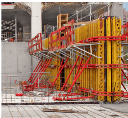
VARIO GT 24 dans le bâtiment.
