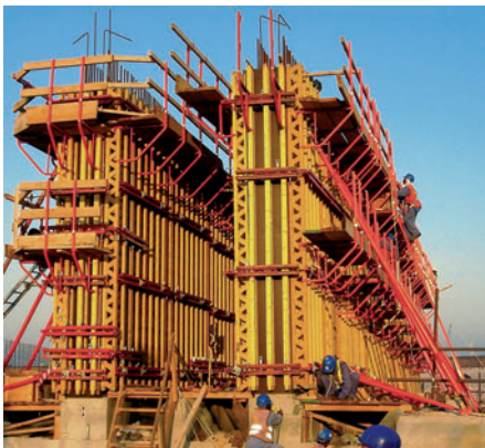
VARIO GT 24 lors de la construction d'un tunnel à Dubaï.
