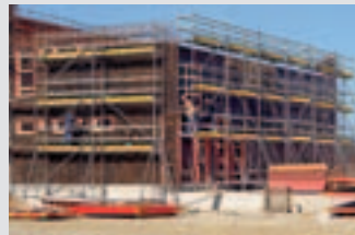
Consoles de travail bâtiment
