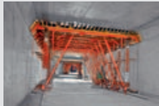
Coffrages de tunnels
