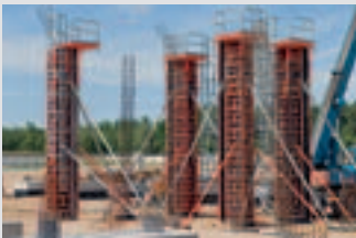
Coffrages de poteaux
