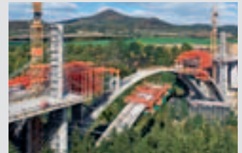
Coffrages de ponts
