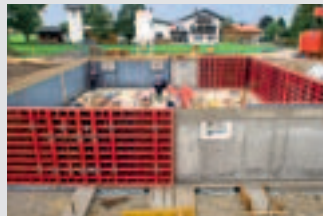
Coffrages de voiles
