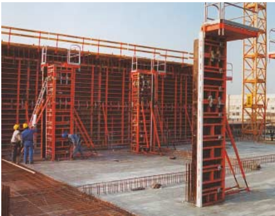
Eléments de coffrage poteaux TRIO superposés sur une hauteur de 4,50 m avec plate-forme de bétonnage.
