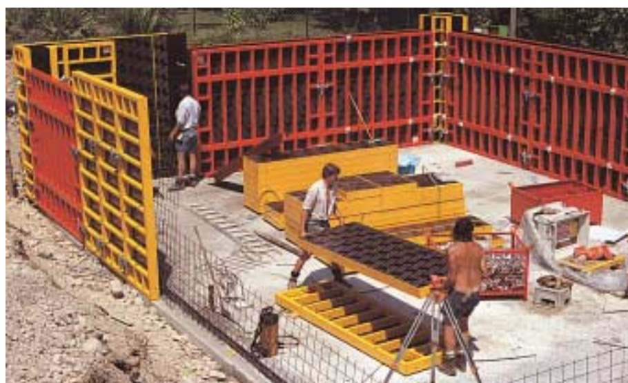
Chantier avec TRIO-L Alu et TRIO Acier. Les angles et compensations sont coffrés à la main à l'aide de TRIO-L et la grue n'est requise que pour l'élément grande surface de 270 x 240 en acier.
