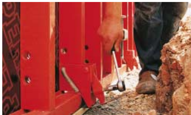
Le serrage s'effectue à l'aide d'une clé à cliquet courante ouv. 14.
