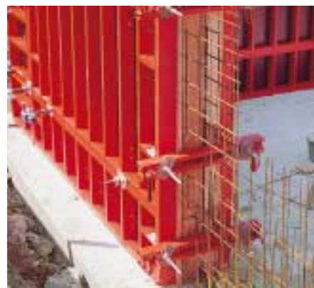
Avec ancrage intérieur (pour grand élément de 270 x 240 ou élément multifonction TRM 72).
