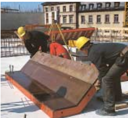
Éléments d'angle de 135° revêtus d'un contreplaqué de grande surface pour la construction d'un hôtel.
