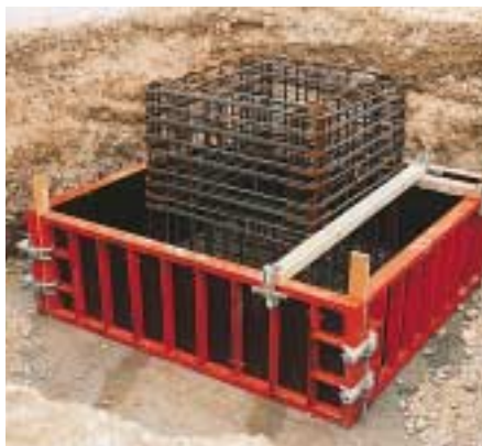
Utilisation des éléments en position horizontale pour fondations
