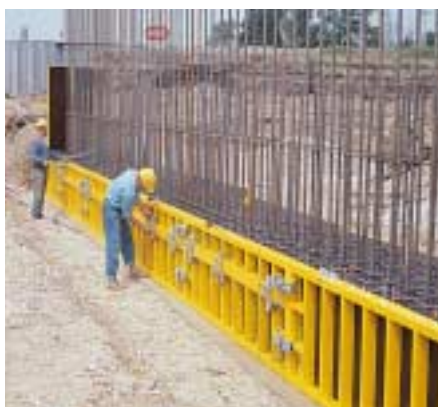
TRIO-L lors du coffrage de fondations.
