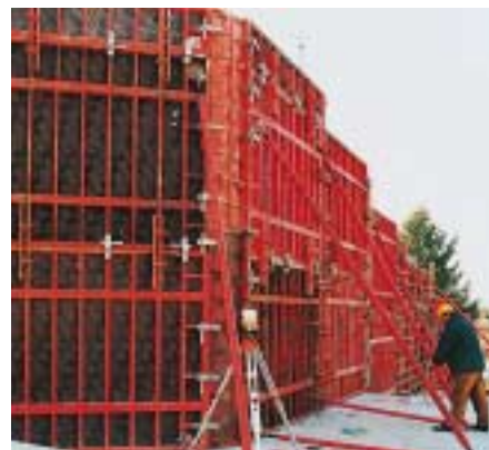
Pour les décrochements en hauteur
