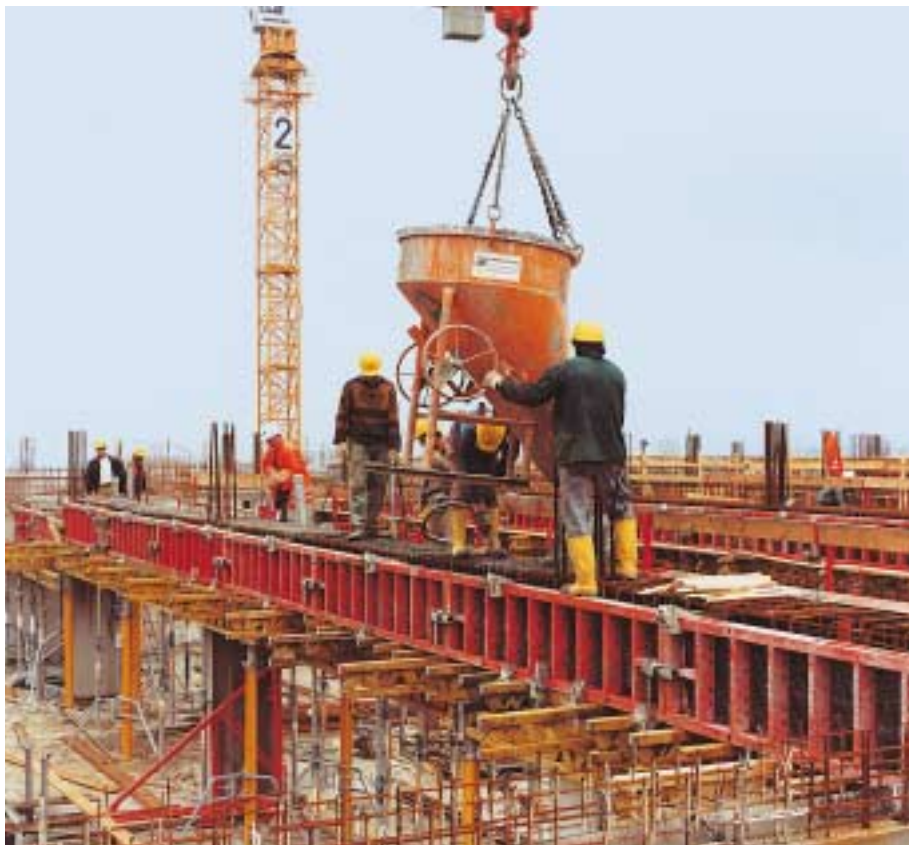
Petites poutres avec TRIO, sur étais PERI – MULTIPROP.
