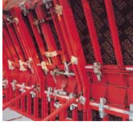
TRIO pour toitures à pans inclinés Des angles articulés et filières spéciales ont servi pour l'angle de la brisure. Les efforts verticaux ont été repris via des filières et étais.
