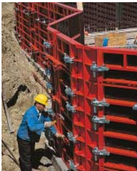
Au niveau de l'angle articulé
