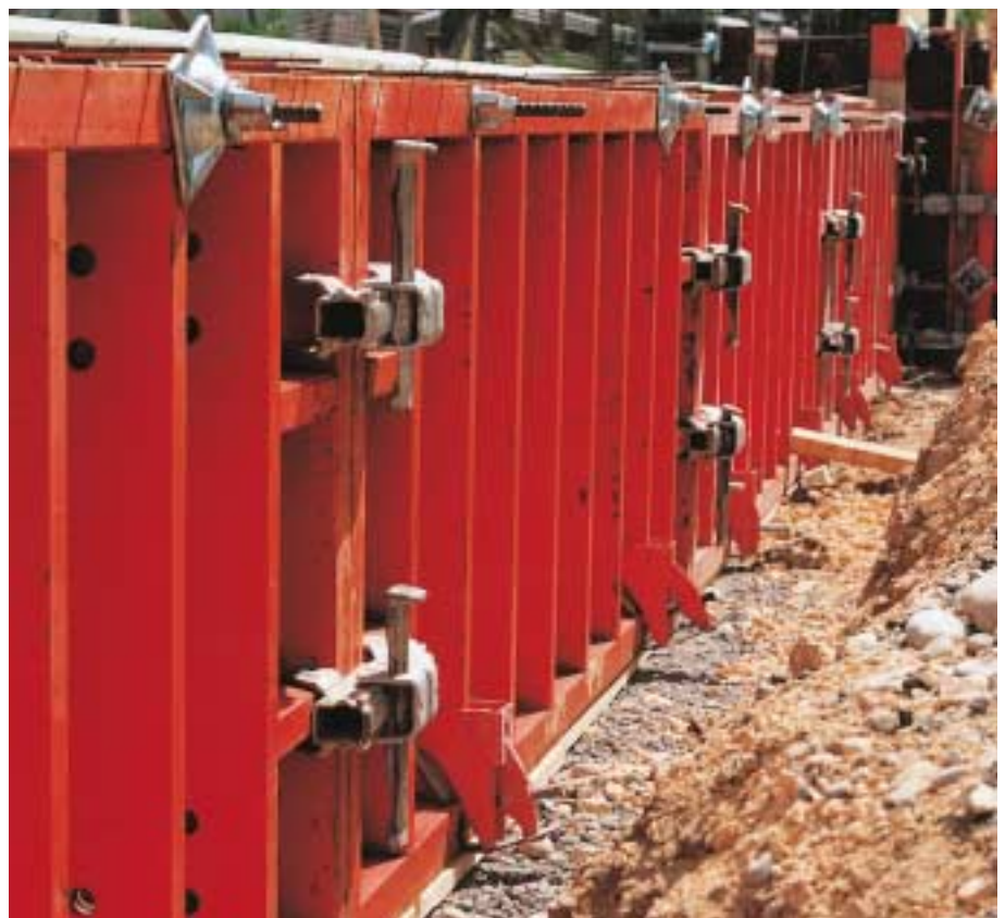
Fondation isolée d'un hall d'usine coffrée à l'aide de pièces de serrage pour feuillard.
