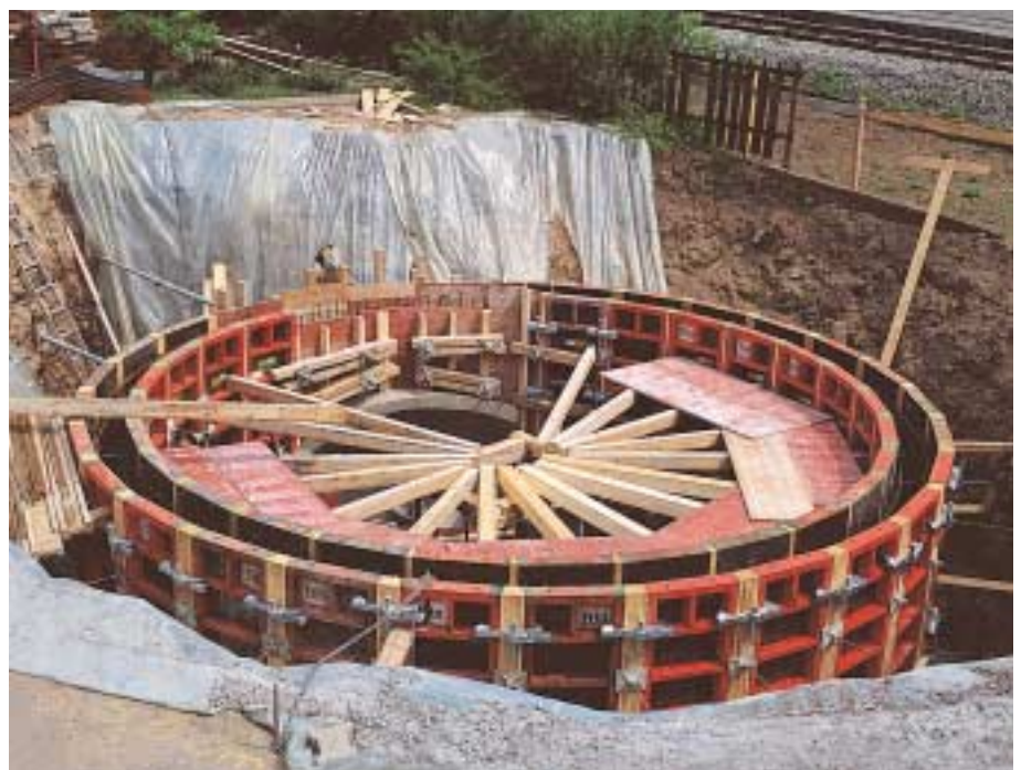
Ouvrage de canal coffré avec des éléments TRIO TR 270 x 60.
