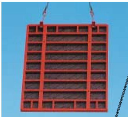
L'élingue multifonction en liaison avec le crochet de levage lors du coffrage.
