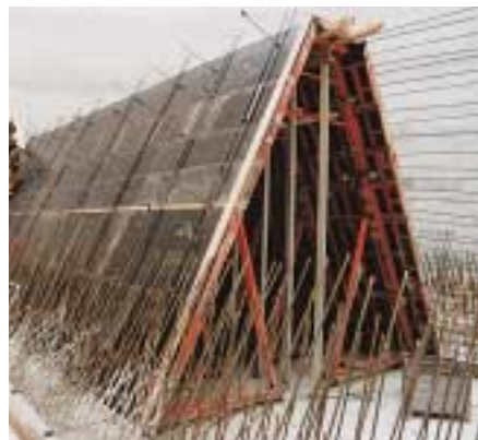
Tunnel de forme trapézoïdale avec TRIO et ferme de butonnage SKS.
