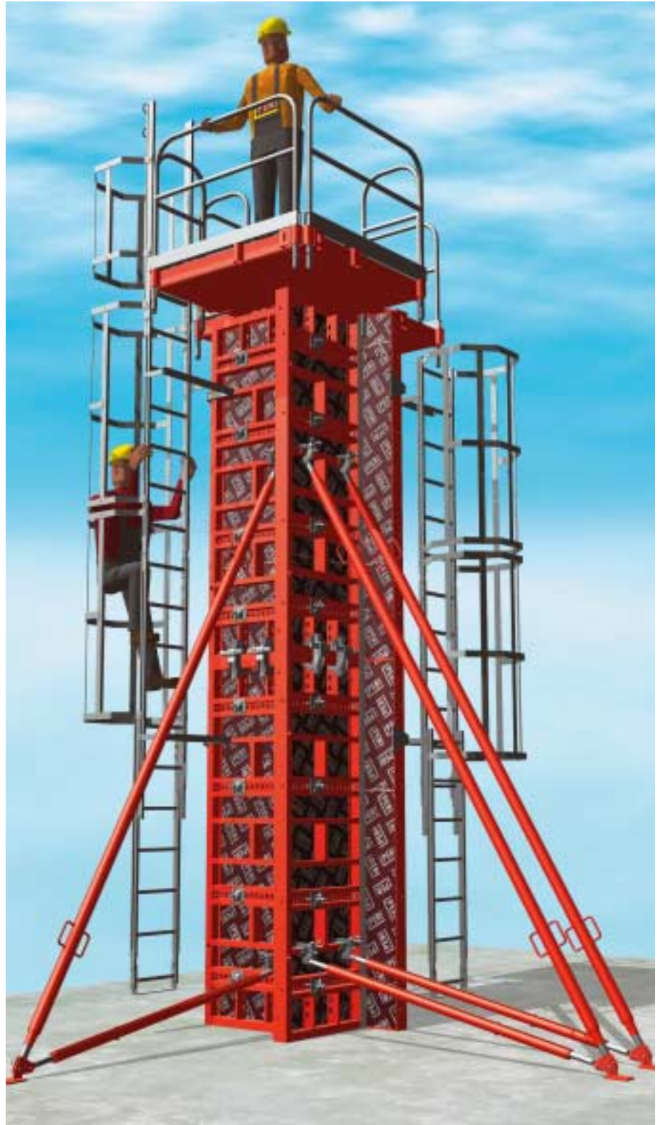
Poteau TRIO complet de 5,40 m de haut. Avec plate-forme de bétonnage, échelles et étais tirant-poussant.
