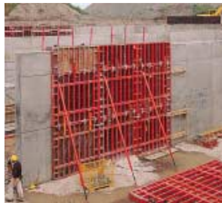
Éléments TRIO couchés et superposés sur une hauteur de 6,0 m
