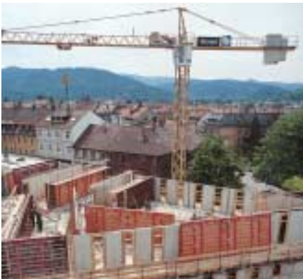
Unités d'éléments d'une largeur jusqu'à 9 m et d'une hauteur de 2,70 m avec peau coffrante de grande surface.
