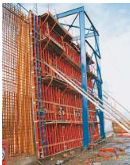
Unité TRIO complète de 8,40 m de haut. Coffrages intérieurs et extérieurs fixés sur un portique roulant.
