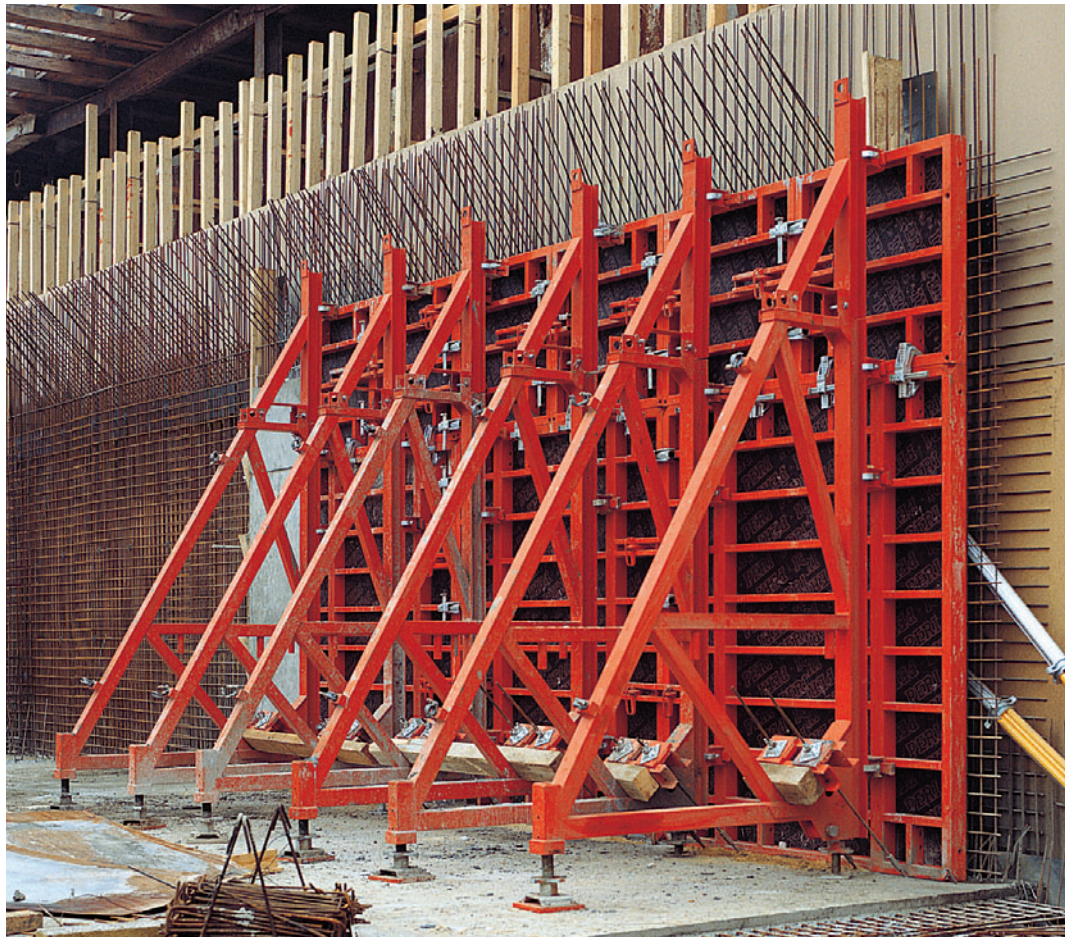
Ferme de butonnage SB-B, C avec TRIO, hauteur de coffrage 3,90 m.
