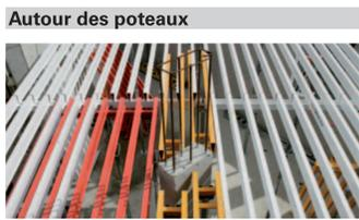
Les éléments de compensation permettent de coffrer sans problème autour des poteaux.
