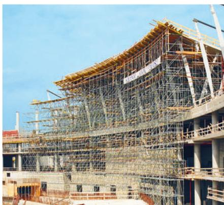
Etalement PERI UP, d'une hauteur allant jusqu'à 38 m, parfaitement adapté au coffrage poutrelles pour dalles MULTIFLEX.
