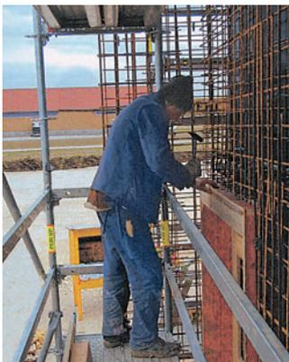
Le garde-corps intérieur rend les travaux de coffrage, de ferrailage et de bétonnage encore plus sûrs et donc plus rapides.
