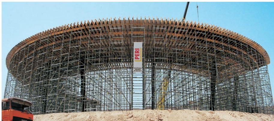
Etalement de 11 m de haut pour un anneau en béton d'un diamètre de 50 m.
