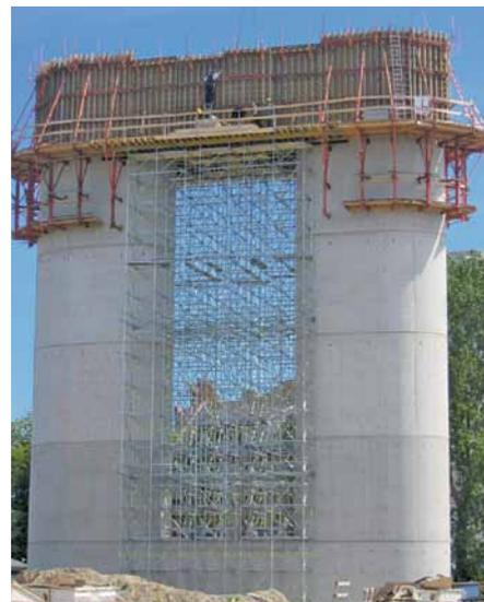
Solution PERI UP sûre et stable pour l'étalement d'un coffrage de chevêtre.
