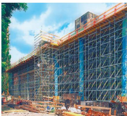
Echafaudage grande surface PERI UP, haut de 14 m, comme sous-structure stable destinée au coffrage poutrelles pour dalles MULTIFLEX. Des tours d'accès ont permis un accès sûr et rapide au plan de travail situé en hauteur.
