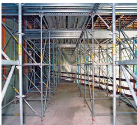
Un étalement PERI UP avec trame de 1,50 m x 1,50 m offrait de vastes espaces de travail et voies de communication sous les plate-formes de travail intégrées.
