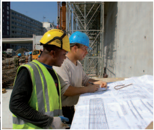
Couverture des voies SNCF gare d'Austerlitz, avenue de France à Paris.
