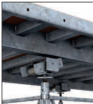
> 2 - Décintrer d'au moins 7 cm et insérer le rouleur suivant le sens d'évacuation.
