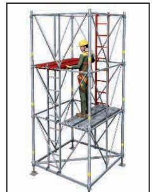
> 7 - Pose de l'échelle, puis remonter d'un niveau les 2 plançons.
