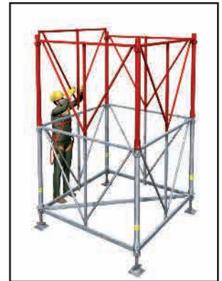
> 3 - Mise en place des poteaux et des cadres du niveau n+1 à partir du niveau inférieur.
