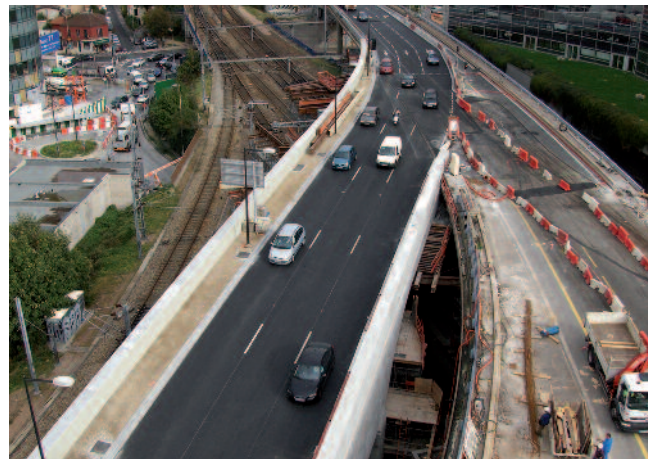
Inauguration et ouverture à la circulation d'une nouvelle artère.
