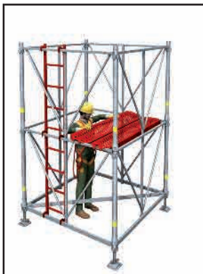
> 4 - Pose de l'échelle et de 2 plançons.
