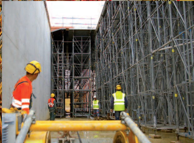
Étalement d'un pont cadre sur la ligne LGV Le Mans-Rennes et ripage à l'aide des cadres à galets à cric.
