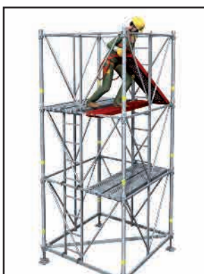
> 8 - Le monteur accède au niveau supérieur puis pose les 2 plançons manquants.
