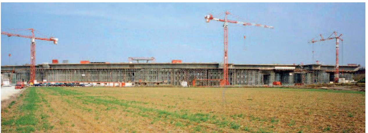
Etalement pour la construction du viaduc de Choisey sur l'autoroute A39 près de Dôle (39).
