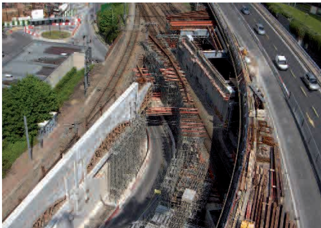
Pour la déviation du boulevard circulaire au-dessus des voies SNCF et RER de La Défense, mise en œuvre de l'étaie Mills Tour.
