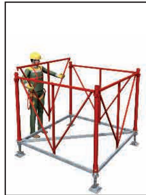
> 2 - Mise en place des poteaux et des cadres du 1 er niveau.
