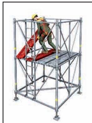
> 5 - Le monteur accède au niveau supérieur puis pose les 2 plançons manquants.
