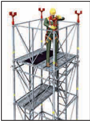
> 12 - Mise en place et réglage des vérins de tête .
