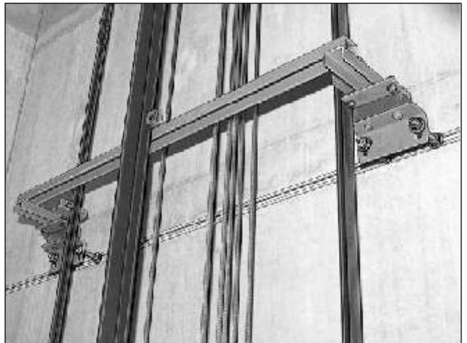
Rails de guidage pour ascenseur
