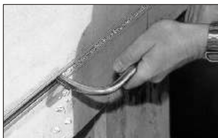
Arrachage du bourrage polystyrène, à l'aide d'un outil approprié.
