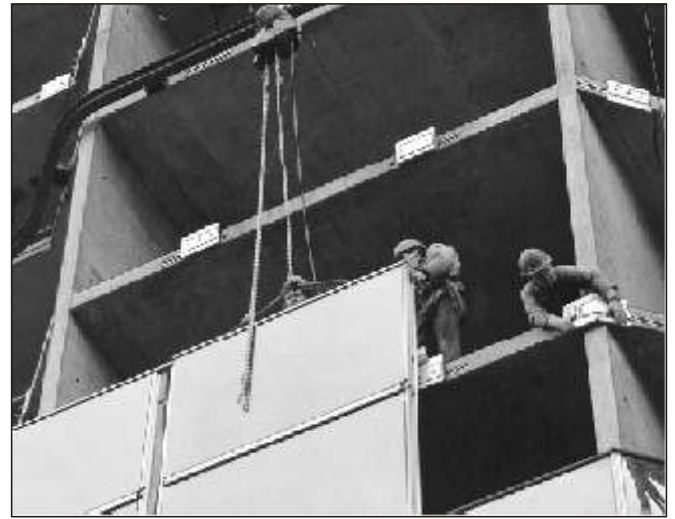
Panneaux de façade fixés à des rails-inserts
