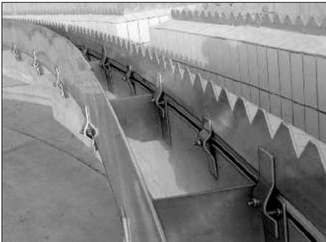
Rails cintrés en acier inoxydable dans une station d'épuration
