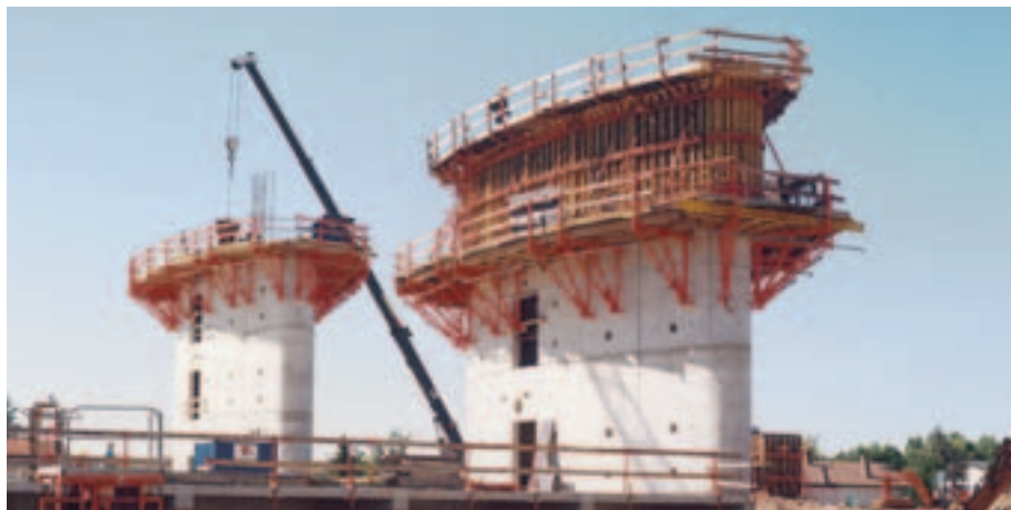
Bâtiments culturels Béton architectonique de haute qualité avec consoles CB 240 et VARIO GT 24.
