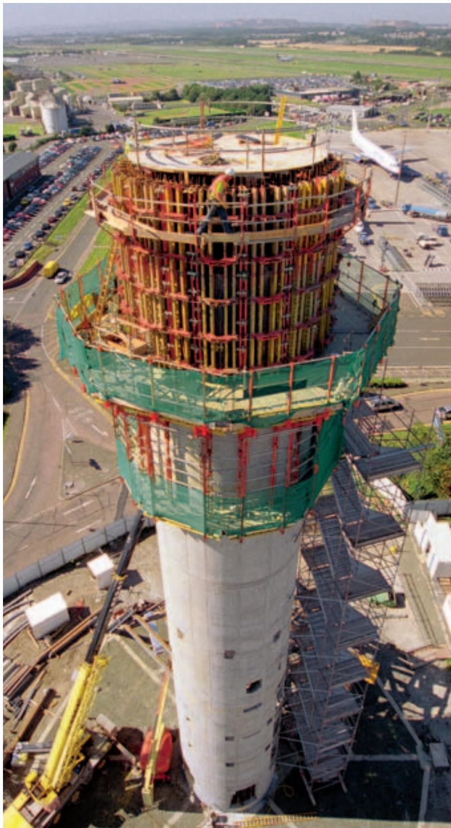
Tour de contrôle d'aéroport 46 m de haut, Ø 6,85 m extérieur. Avec PERI RUNDFLEX et consoles CB 240.
