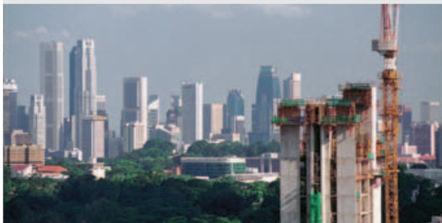
Tour d'habitations Consoles CB 240 et CB 160 avec VARIO GT 24.
