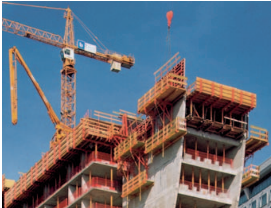
Construction d'hôtels Consoles CB 240 complètes avec passerelle suspendue et TRIO.
